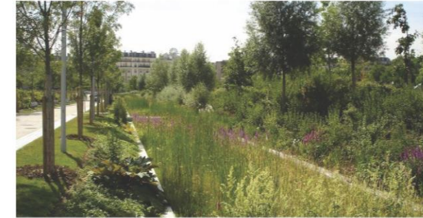
Des noues paysagères qualitatives pour la récupération des eaux pluviales
